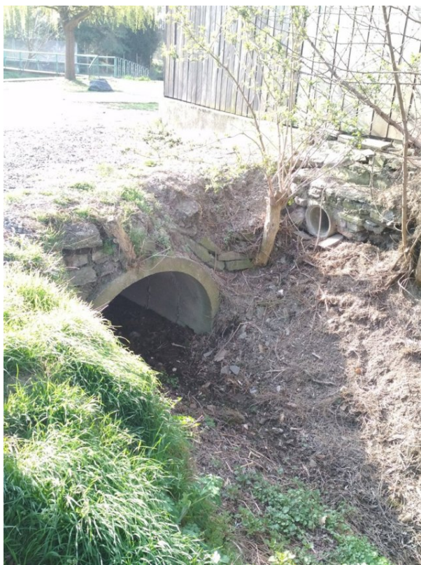
Obr. 10: Propustek na ulici Vodní
