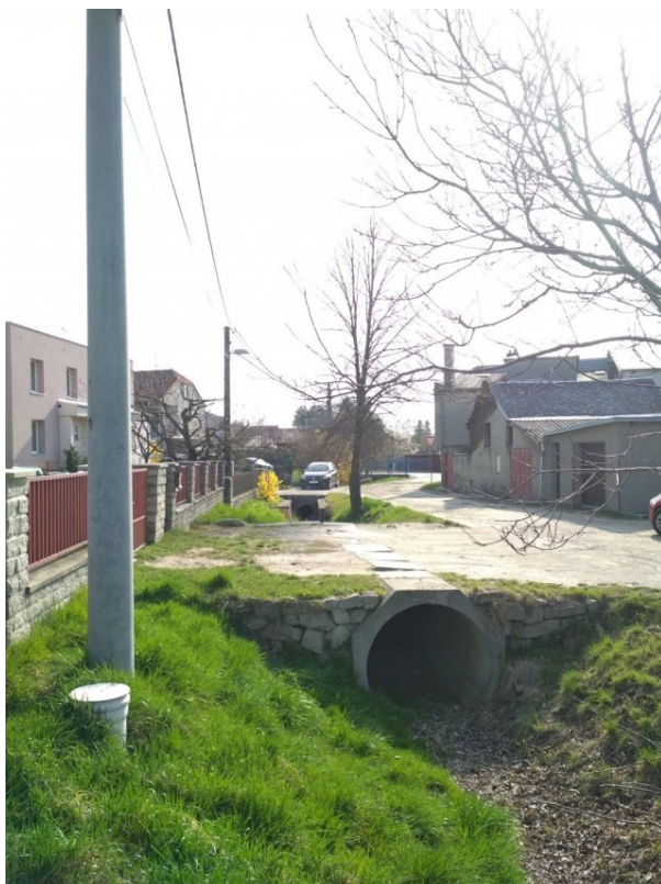
Obr. 12: Soustava propustků u ulice Padělky a Biskupství
