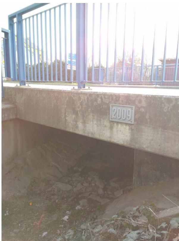
Obr. 8: Most přes Babělec na ulici Biskupství- místo omezující odtokové poměry
