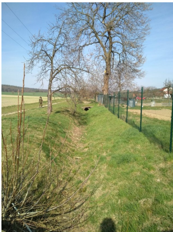
Obr. 13: Soustava propustků na jihu místní části Nové Dvory
