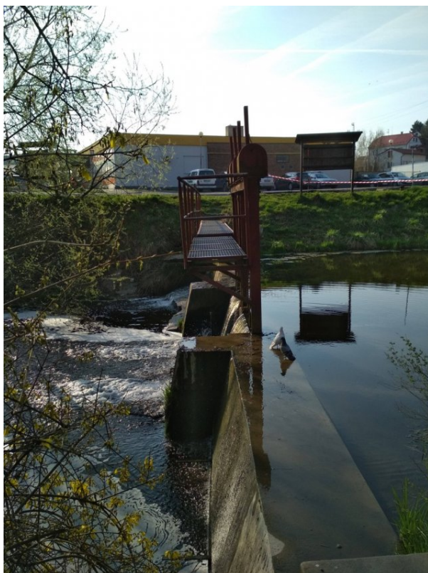
Obr. 6: Jez u hasičárny - výskyt ledových jevů
