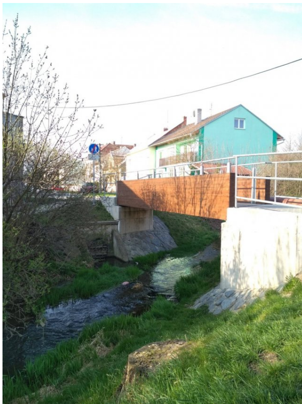
Obr. 11: Most z ulice Vodní na ulici Komenského - místo omezující odtokové poměry
