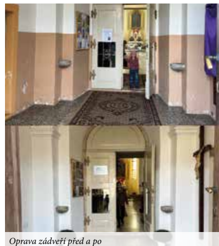
Oprava zádveří před a po
